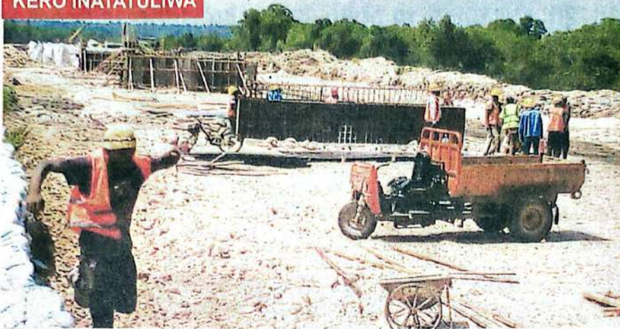
SERIKALI inaendelea kujenga miundombinu ya usafiri kutatua kero za wananchi, pichani mafundi wa kampuni ya CCECC wakiendelea na ujenzi wa daraja la Uzi kisiwani kurahisisha usafiri maeneo hayo.
